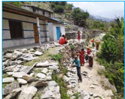
पर्खाल निर्माण, तलकोट गा.पा., बझाङ ।
