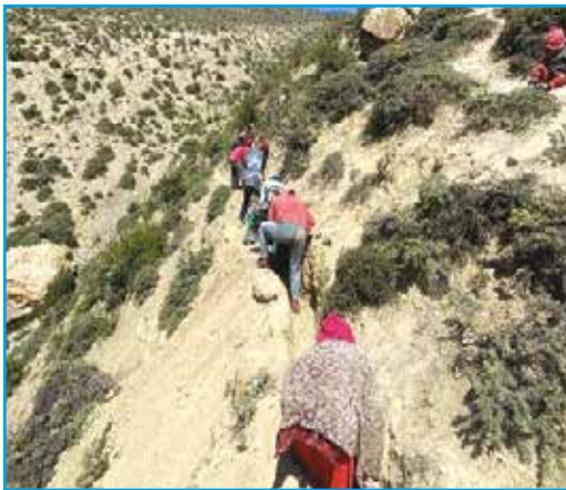
खानेपानी पाइप बिछाइरहेको, घरपोझड गा.पा., मुस्ताङ ।
