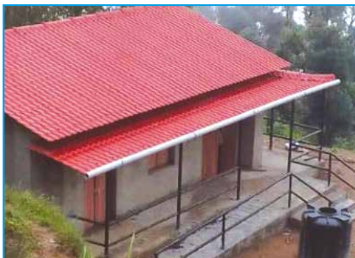
भवन निर्माण, छेडगाडा न.पा., जाजरकोट ।
