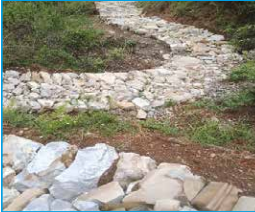
गोरेटो बाटो निर्माण, पुचौडी न.पा., बैतडी ।
