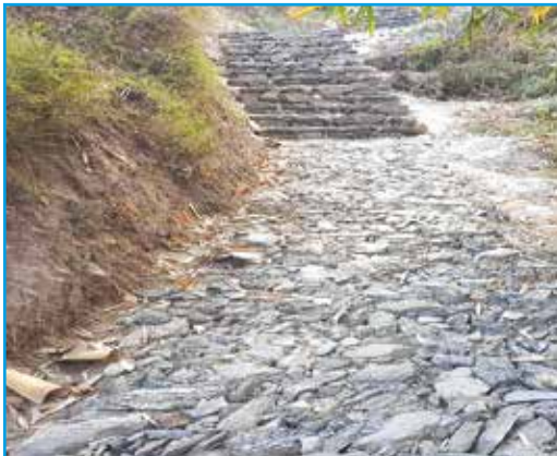
गोरेटो बाटो निर्माण, हतुवाग गा.पा., भोजपुर ।
