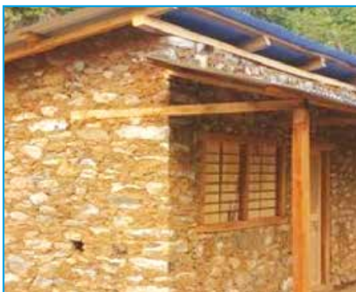
भवन निर्माण, परिवर्तन गा.पा., रोल्पा ।
