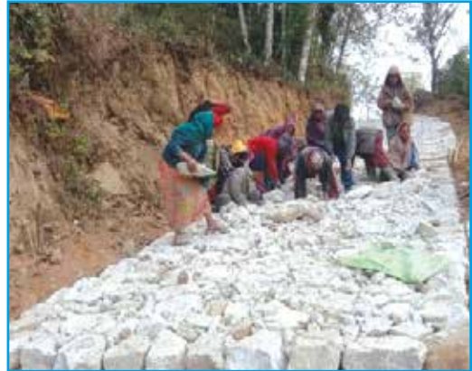
बाटो निर्माण, चौबिसे गा.पा., धनकुटा ।
