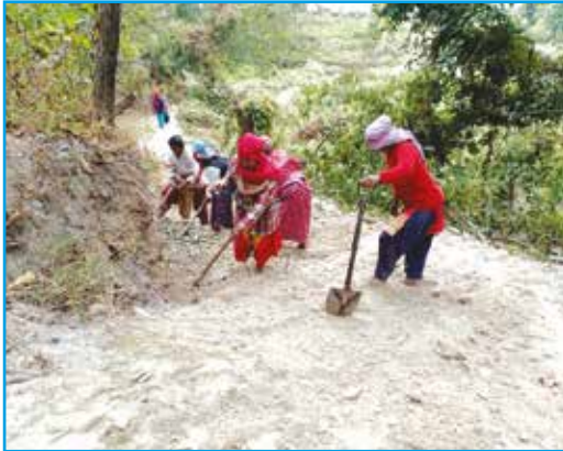
बाटो निर्माण, हरिहरपुरगढी गा.पा., सिन्धुली ।
