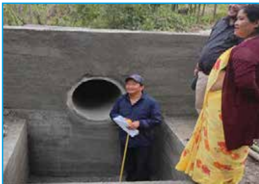
पुल निर्माण, रोड गा.पा., इलाम ।
