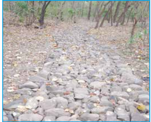
पदमार्ग बाटो निर्माण, बेदकोट न.पा., कञ्चनपुर ।
