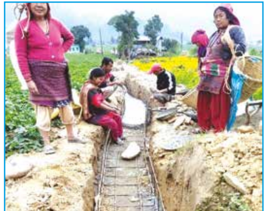
ढल निकास निर्माण, लिखु गा.पा., नुवाकोट ।
