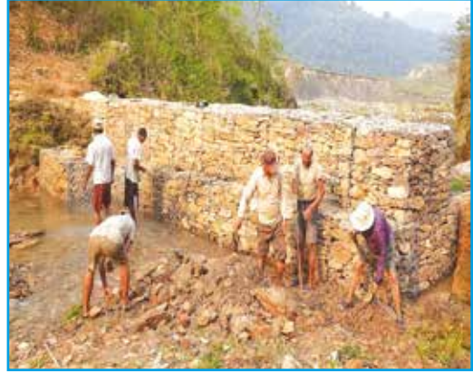
नदीको बाध निर्माण, रूपा गा.पा., कास्की ।
