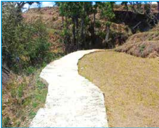
डोटी जिल्ला आदर्श गाउँपालिका वडा न ४ डोक्ट गोरेटो बाटो मल्लो सडकदेखि तल्लो सडकसम्म सडक बाटो निर्माण योजना ।
