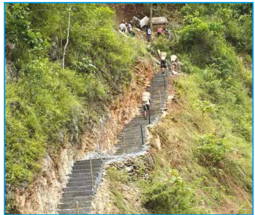
गोरेटो बाटो निर्माण, चौतारा सा.न.पा., सिन्धुपाल्चोक ।
