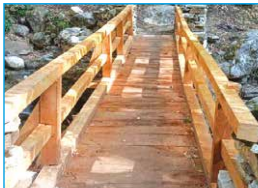
काठे पुल निर्माण, बारेकोट गा.पा. जाजरकोट ।
