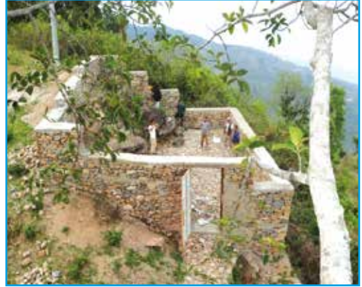
घर निर्माण, हतुवागढी गा.पा., भोजपुर ।
