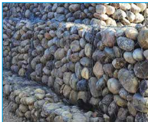
खोला तटबन्ध निर्माण, मरिण गा.पा. सिन्धुली ।
